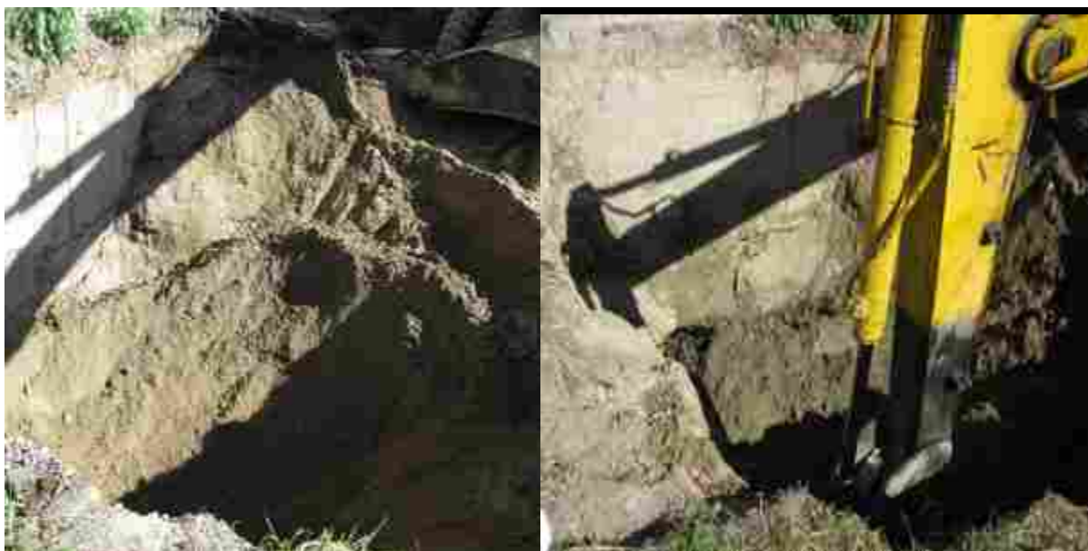
Фото 5.1.2. Шурф в осях «15/Д»
