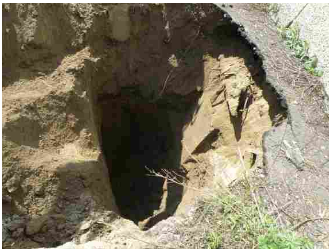
Фото 5.1.1. Шурф в осях «24/Д»
