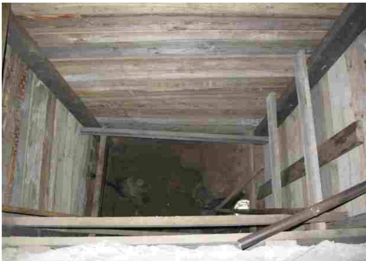
Фото 5.1.3. Шурф в осях «24/Е».
