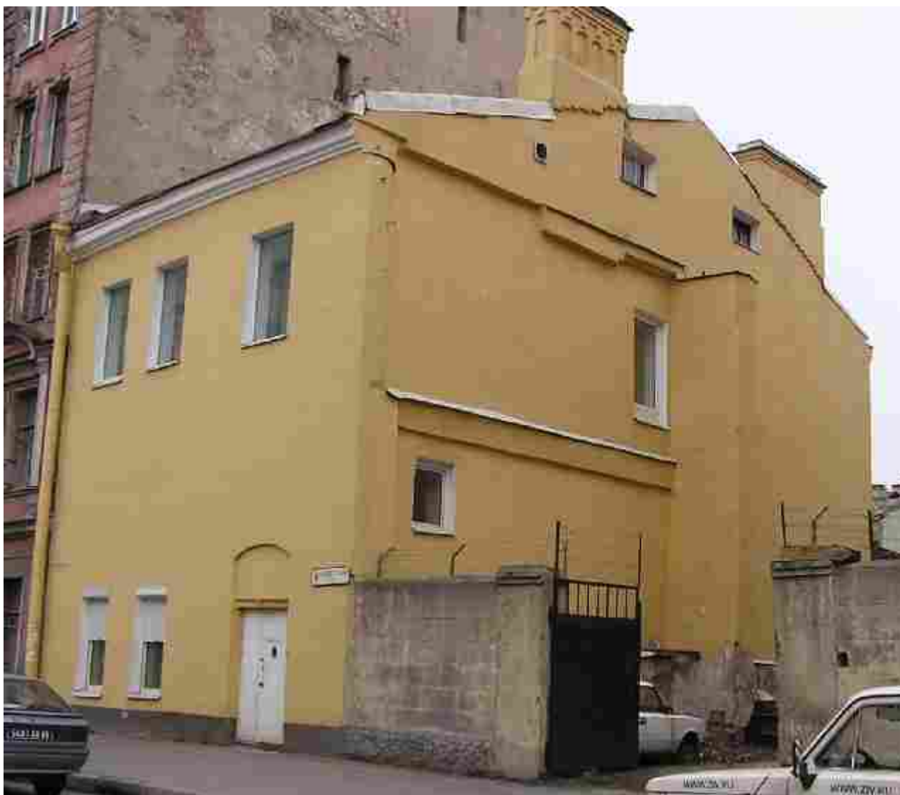
Общий вид здания по адресу: ул. 4-я д. 39 лит. «А».
