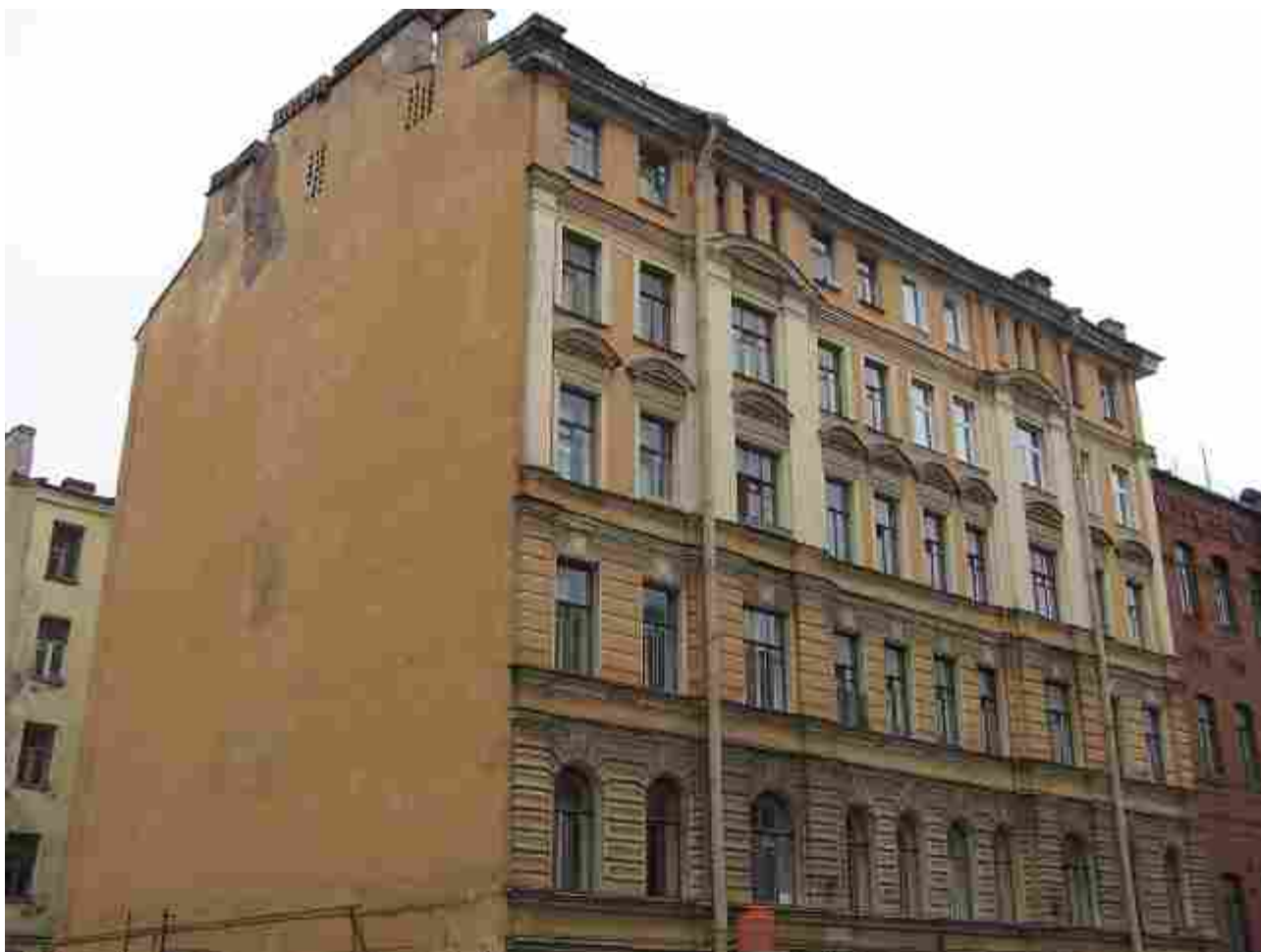
Общий вид здания по адресу: ул. 4-я д. 37 лит. «А»
