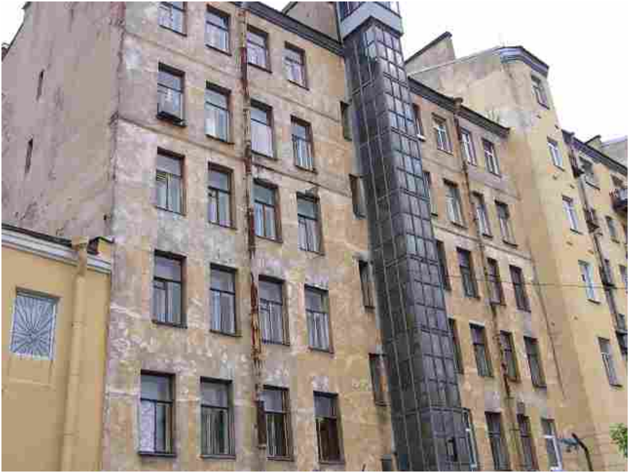
Общий вид здания по адресу: ул. 4-я д. 41.
